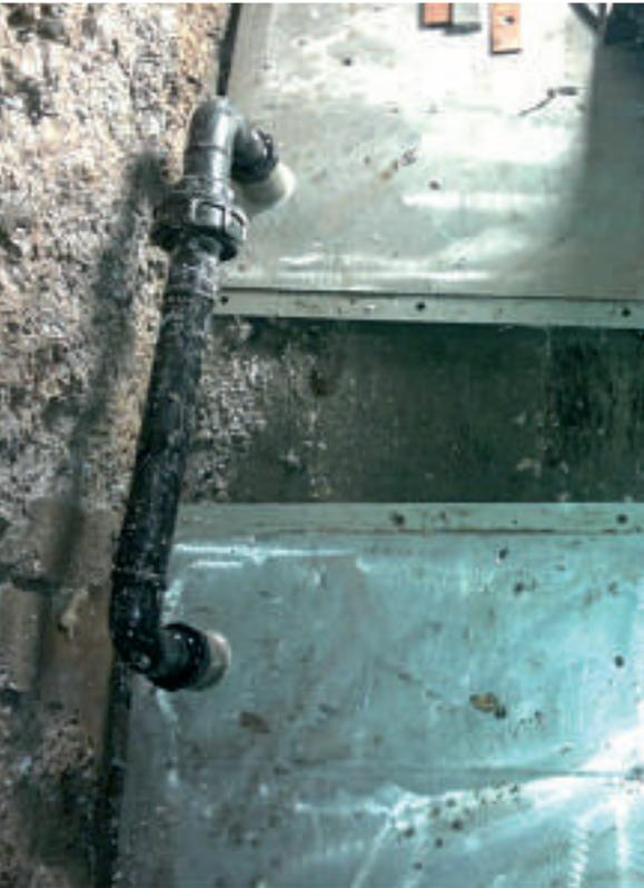
In Salzburg wurden Plattenwärmetauscher eingesetzt; zwischen den einzelnen Platten zirkuliert in den Kunststoffrohren das Zwischenkühlmittel.
