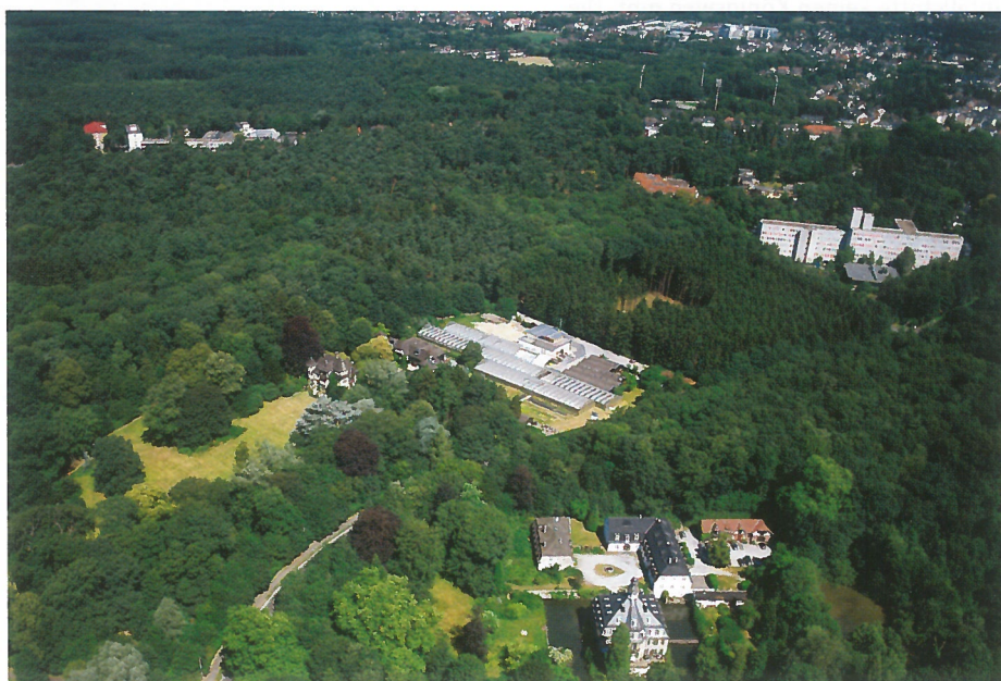
Das in der Bildmitte gelegene Holzackschnitzel-Heizwerk der Lebenshilfe-Gärtnerei versorgt Gewächshäuser (4000 qm Fläche) und eigene Betriebsgebäude sowie die umgebenden Gebäudekomplexe mit einer Fläche von insgesamt 52 000 Quadratmetern (Klinik, Altenheim, Verwaltungsgebäude der Stadt Solingen und Schloss Hackhausen mit Sitz einer Werbeagentur) über ein sechs Kilometer langes Nahwärmenetz. Fotos, soweit nichts anderes angegeben, Thorsten Meis/Martin Schmidt, Stadtwerke Solingen
