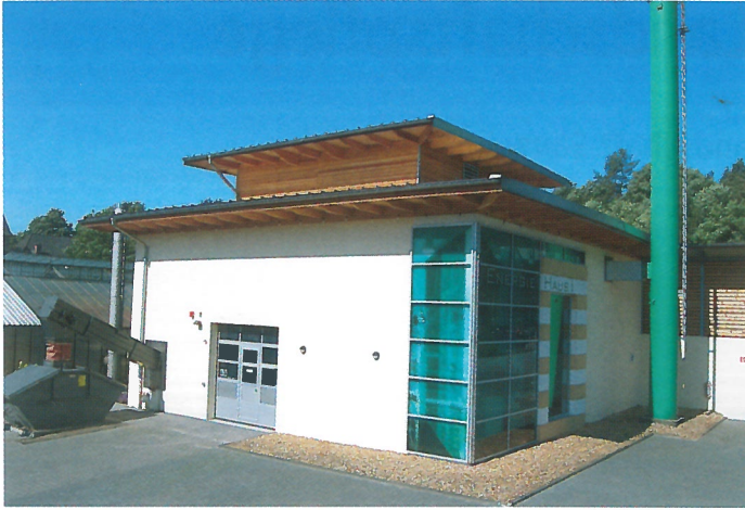
Das Gebäude des Holzhack-schnitzel-Heizwerks auf dem Gelände der Lebenshilfe-Gärtnerei in Solingen.
