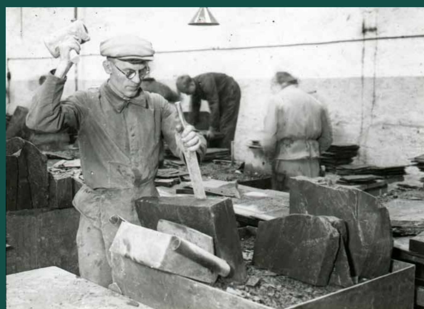
Im Spalthaus wurden Schiefersteinplatten vom sogenannten Leyer oder auch Layer (Arbeiter im Steinbruch) mit einem hölzernen Klöppel und dem Spalteisen in bis zu vier bis sechs Millimeter starke Leyen (Dachschiefer) gespalten. Leyendecker (auch Leiendecker) war eine frühere Bezeichnung für den Beruf des Schieferdeckers. Mit einem Schieferhammer werden sie dann vom Dachdecker für die letztendliche Dachdeckung vor Ort zugerichtet und angepasst (siehe linkes Foto). Quelle: Gerald Halama für Rathscheck Schiefer, Mayen
