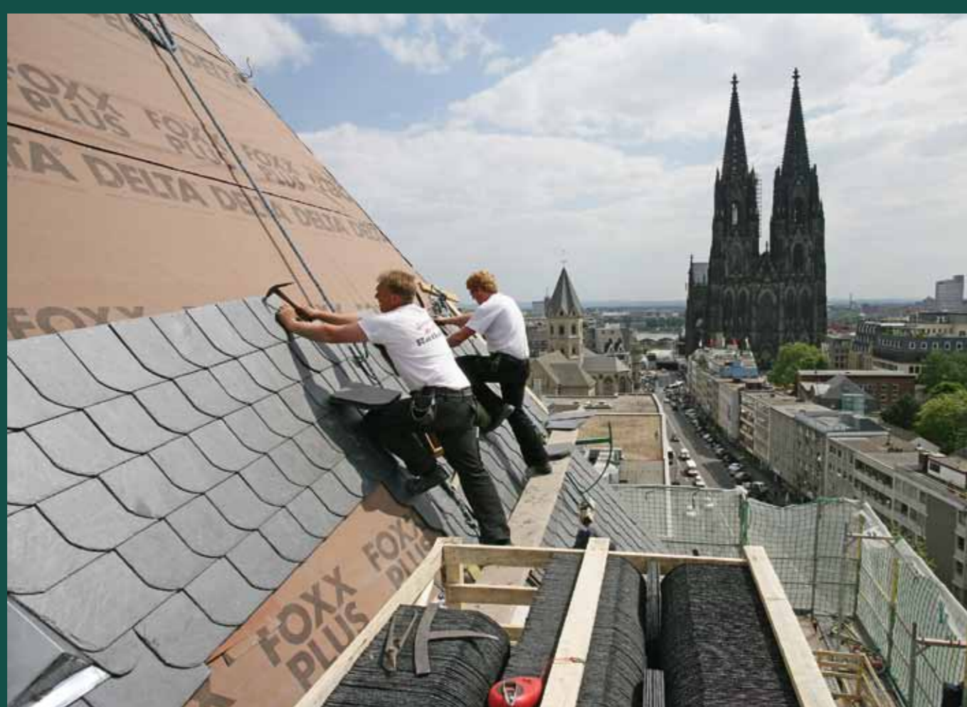
Dachdeckerarbeiten am 36 Meter hohen Walmdach des Dominiums. Dachschiefer sind heute zur Erhaltung historischer Gebäude unverzichtbar. Quelle: Gerald Halama für Rathscheck Schiefer, Mayen
